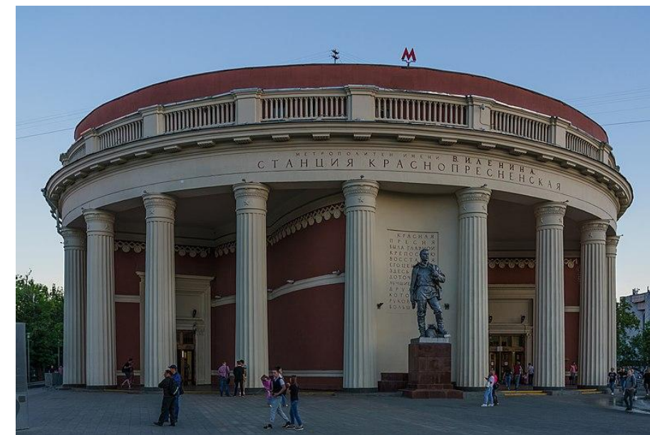
Выделенная опоясывающая балка
